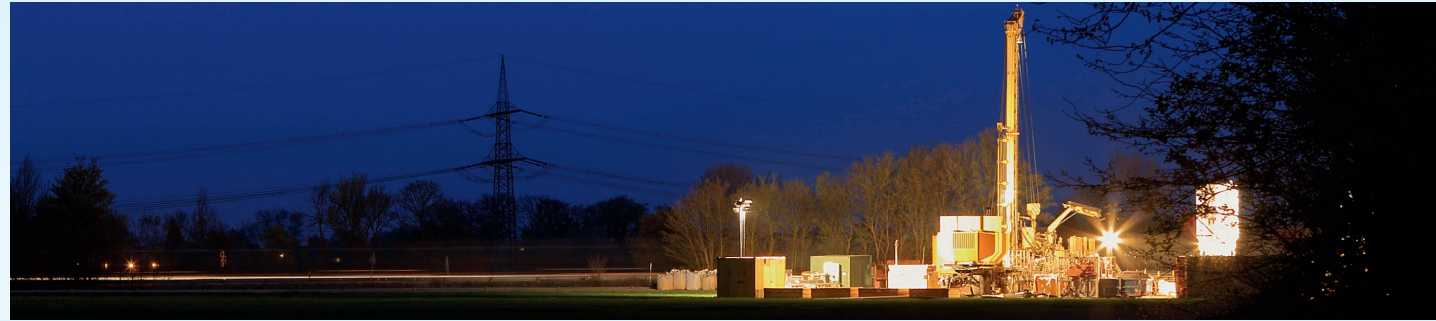
Nachtschicht: Brunnenbohrung bei Kerpen-Manheim.
