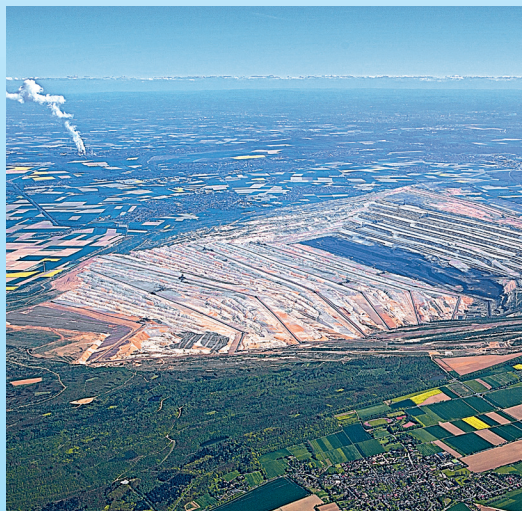
Blick über den Tagebau Hambach.
