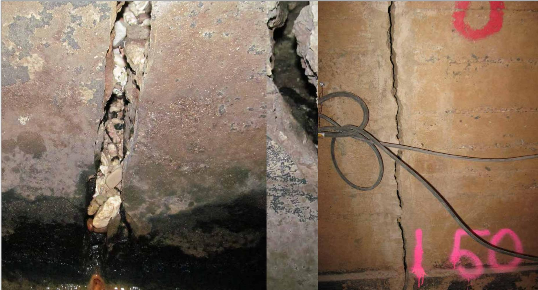
Querrisse an den Betonierabschnitten der Stollenkonstruktion
