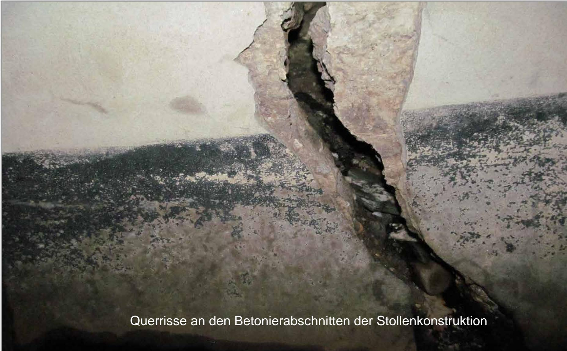
Querrisse an den Betonierabschnitten der Stollenkonstruktion
