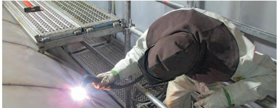
↑ **SCHWEISSTREIBEND:** Ein Kollege in Schutzausrüstung und mit Atemmaske zerlegt einen Sprühflutbehälter mittels Plasmaschneider, der eine über 1.200 Grad heiße Flamme erzeugt.
