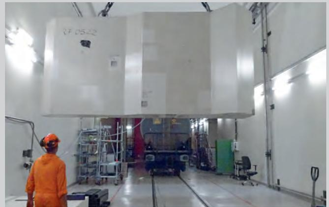
↑ **SCHWERSTARBEIT:** So wie hier im Kernkraftwerk Gundremmingen sind für den Abtransport großer Betonwände Kranarbeiten erforderlich.
