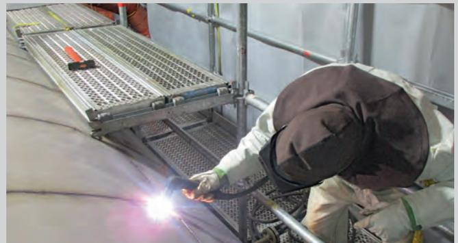
↑ **SCHWEISSTREIBEND:** Ein Kollege in Schutzausrüstung und mit Atemmaske zerlegt den Sprühflutbehälter mittels Plasmaschneider, der eine über 1.200 Grad heiße Flamme erzeugt.
