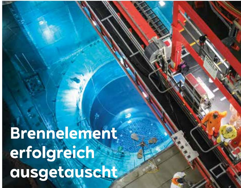
Gut vier Wochen, von Ende Oktober bis Ende November, war Block C des Kernkraftwerks Gundremmingen vom Netz. Grund für den Stillstand war ein Brennelementwechsel, der erfolgreich umgesetzt wurde. Die kontinuierliche Betriebsüberwachung des Reaktorkerns von Block C hatte zuvor Hinweise auf einen Brennelementdefekt ergeben.
