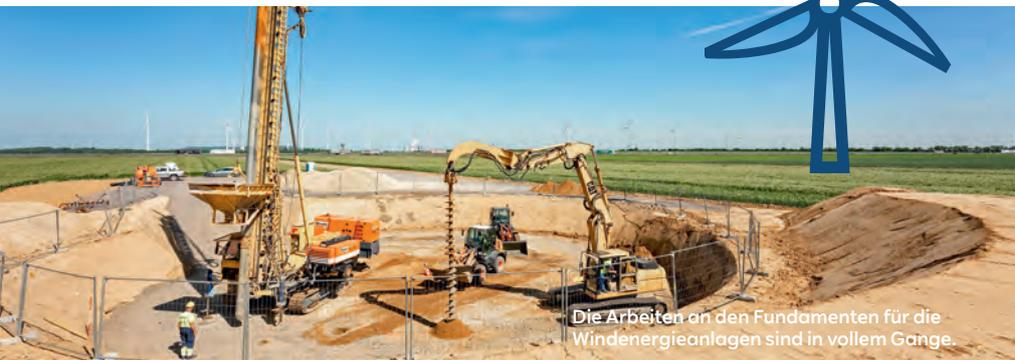
**Jüchen.** Die Errichtung des Kooperationswindparks in Jüchen nimmt Fahrt auf: Nach dem Baustart im April stehen im Sommer die Arbeiten an den Fundamenten für die sechs Windenergieanlagen auf dem Plan. Nach deren Aushärtung werden die unteren 96 Meter des Beton-Stahl-Hybridturms errichtet. Parallel dazu werden die Kabel für die
