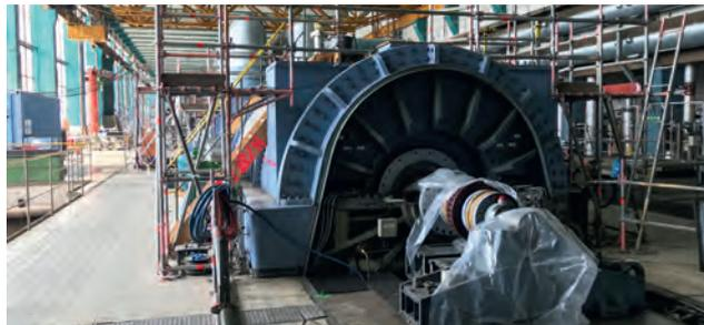
Gut verpackt und sicher eingerüstet – so pausierte die Turbine in Block F des Kraftwerks Weisweiler während der Revision.
