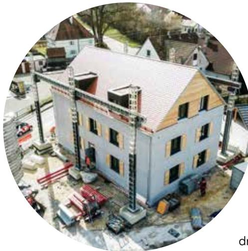
So sieht das Haus aus dem 3D-Drucker aus. Schicht für Schicht entstehen die Einzelteile im Drucker und werden dann zu einem fertigen Haus zusammengesetzt.
