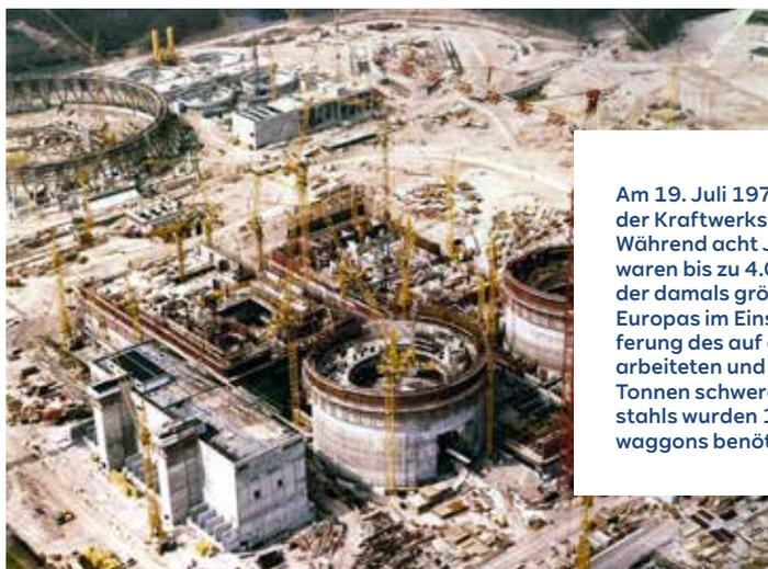
Am 19. Juli 1976 begann der Bau der Kraftwerksblöcke B und C. Während acht Jahren Bauzeit waren bis zu 4.000 Fachkräfte auf der damals größten Baustelle Europas im Einsatz. Für die Anlieferung des auf der Baustelle verarbeiteten und insgesamt 60.000 Tonnen schweren Bewehrungsstahls wurden 1.200 Eisenbahnwaggons benötigt.
