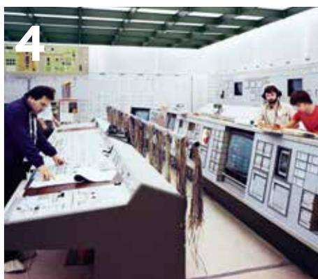
1 Der Kühlturm wuchs damals täglich um eineinhalb Meter bis zur endgültigen Höhe von 160 Metern. 2 Die einzelnen Segmente des Reaktordruckbehälters wurden auf der Baustelle zusammen geschweißt. 3 Mit einem großen Rundlaufkran wurde im Reaktorgebäude der 111 Tonnen schwere Deckel des Reaktordruckbehälters eingehoben. 4 Inbetriebsetzung und Funktionsprüfung der Bedienelemente auf der Hauptwarte, der Zentrale eines Kraftwerksblocks.
