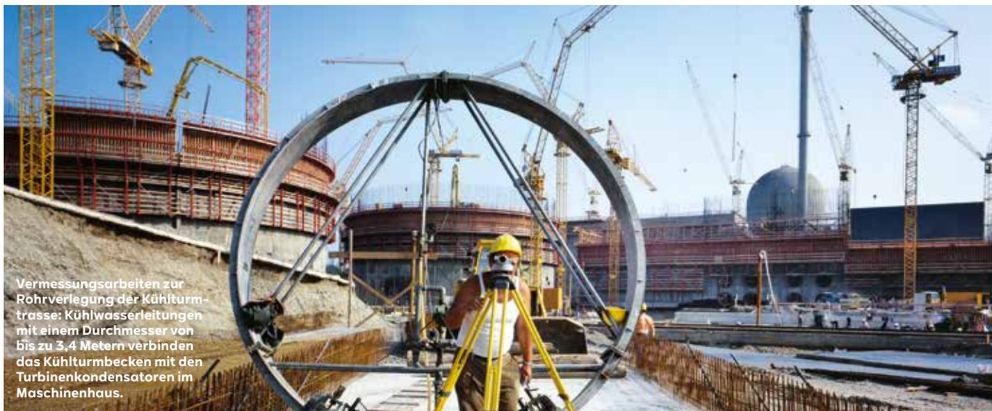
Vermessungsarbeiten zur Rohrverlegung der Kühlturmtrasse: Kühlwasserleitungen mit einem Durchmesser von bis zu 3,4 Metern verbinden das Kühlturmbecken mit den Turbinenkondensatoren im Maschinenhaus.
