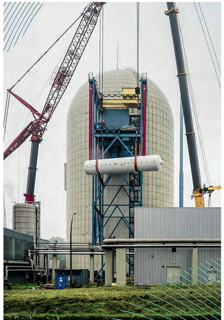
Zwei Dampfumformer im Kernkraftwerk Lingen wurden ausgebaut – damit ist ein deutlicher Abbaufortschritt erreicht.
