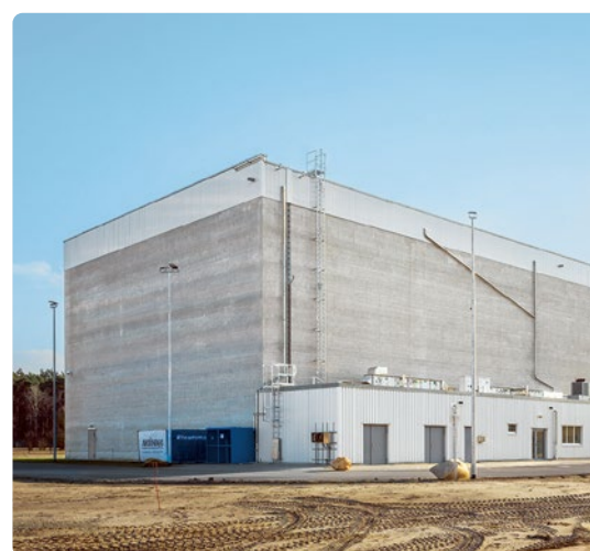
Im TLE werden künftig schwach- und mittelradioaktive Abfälle fachgerecht in Endlagerbehälter verpackt.
