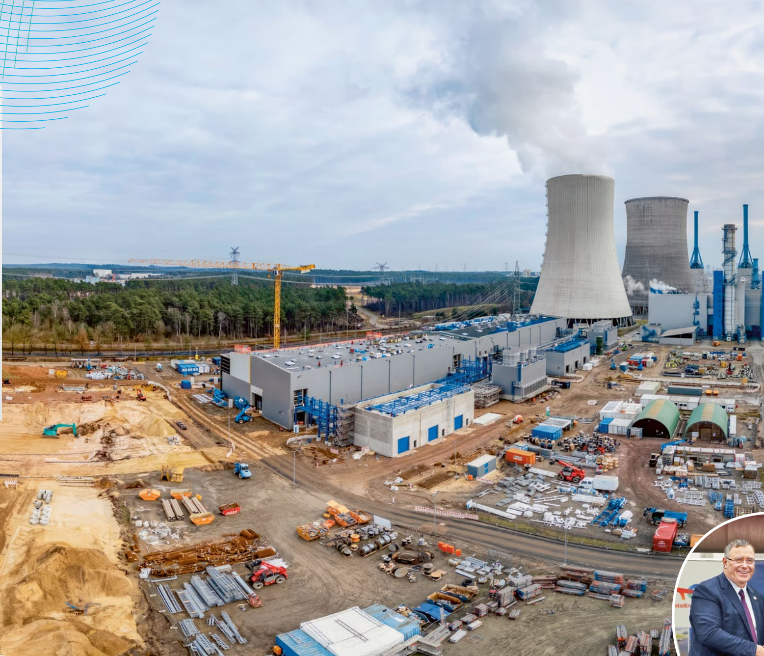
Am Standort Lingen baut RWE mit der 300-Megawatt-Elektrolyseanlage an der Zukunft.
