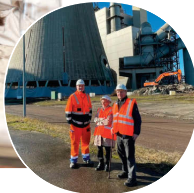
Baustellenbesuch – einen Tag vor der Kühlturmsprengung.
