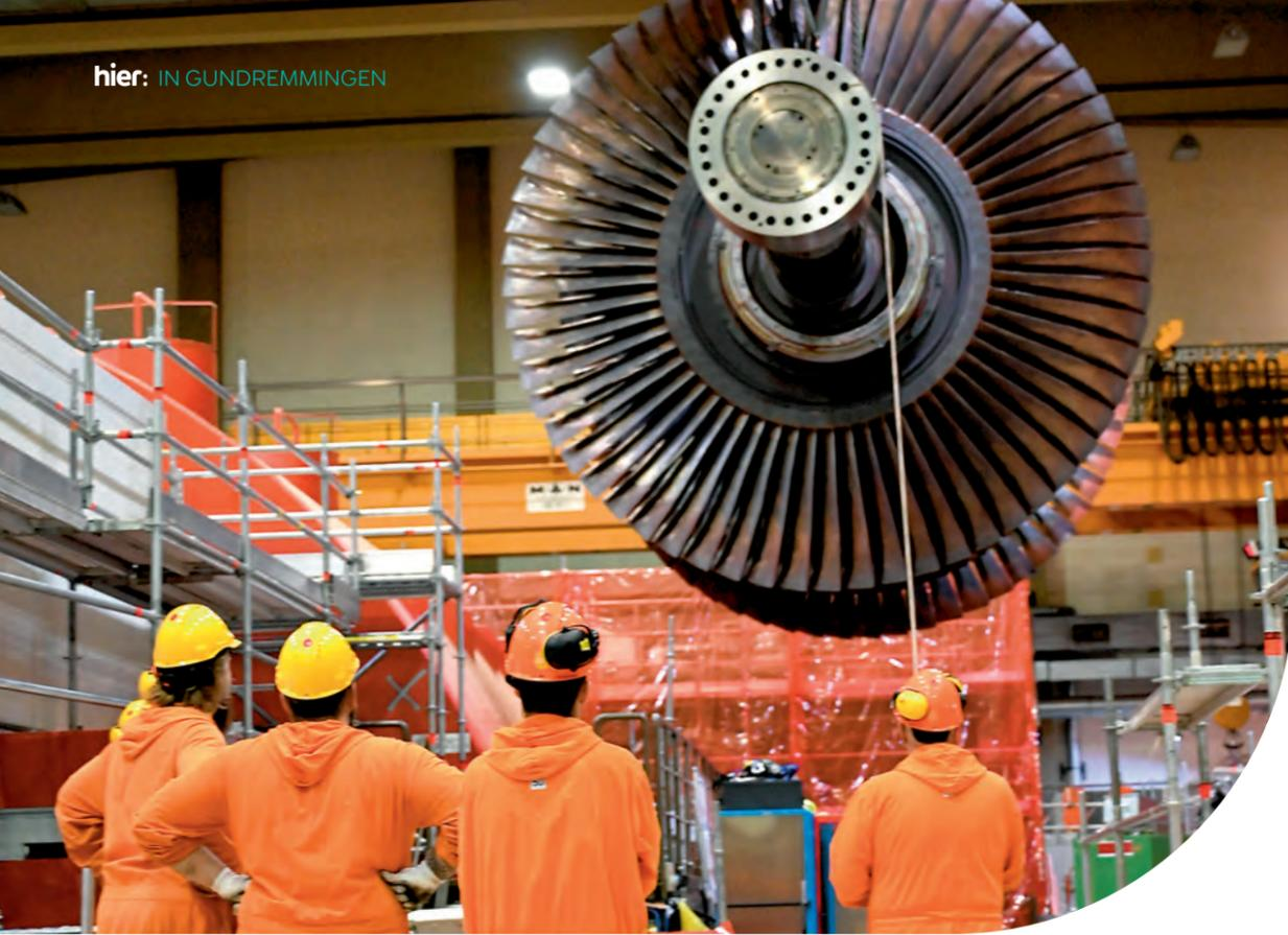
Kein leichter Einsatz: Jede einzelne Schaufel des Turbinenläufers wiegt 85 Kilo.
