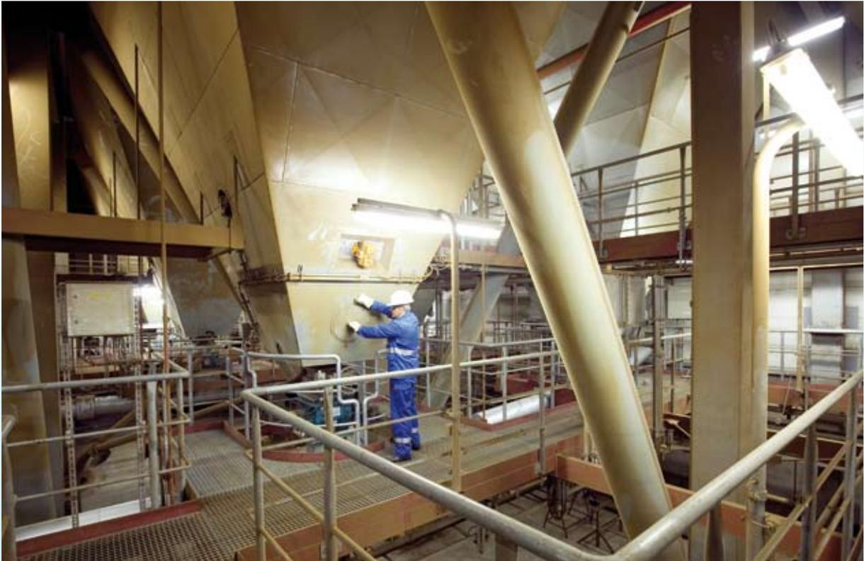
Die Entschwefelung findet in so genannten Wäschern statt. Auf mehreren Ebenen verrieseln Düsen eine Suspension aus Wasser und Kalksteinmehl, die auf das entgegengerührte Rauchgas regnet. Das Schwefeldioxid reagiert mit Kalk und Sauerstoff zu Gips. Anschließend hat das Reingas einen  $\text{SO}_2$ -Gehalt deutlich unterhalb der Grenzwerte. Es wird in den Kühlturm geleitet und gelangt so in die Atmosphäre.
