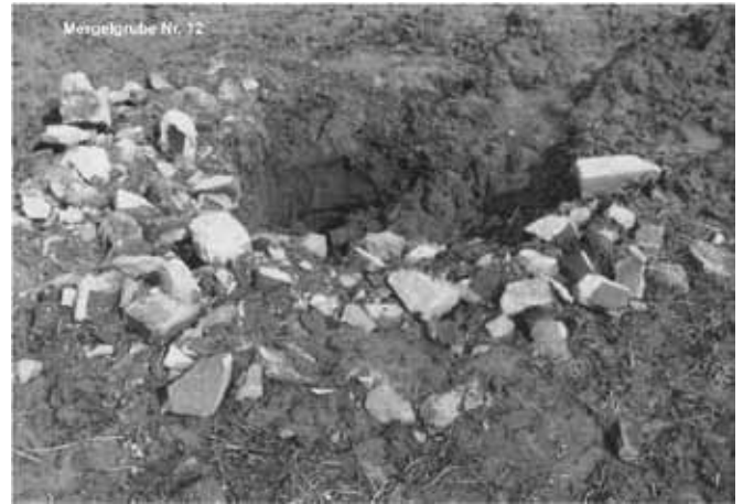
Abb. 12: Notdürftig gesicherter Schachteinbruch bei Jülich-Boslar (Schulze Rettmer 1972)
