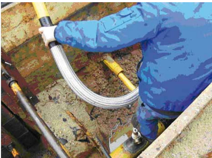
Abb. 5: Einbau einer flexiblen Gasanschlussleitung im Querungsbereich des Rheindahlener Sprungs an der Talstraße
