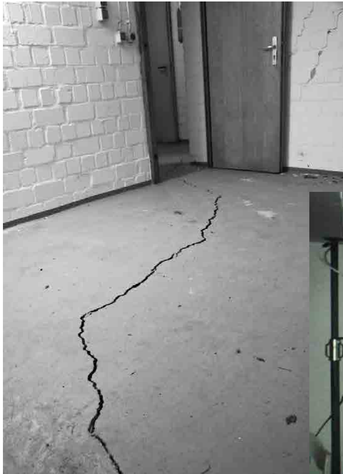
Bild 9 Breiter werdende steigende Risse »zei- gen« auf Bauteilflächen-Teile, die abgeris- sen, gesenkt oder geschoben sind.
