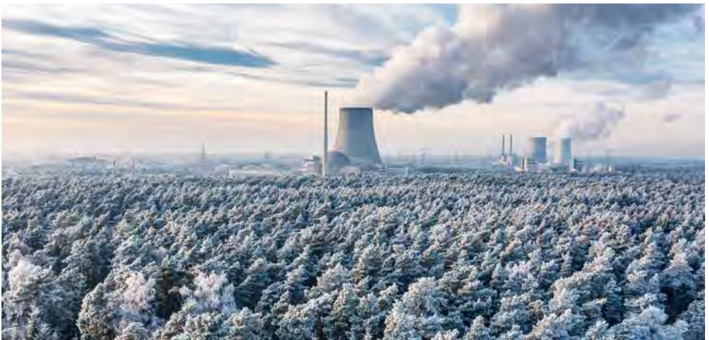
Das Kernkraftwerk Emsland kann bis Frühjahr 2023 in Betrieb bleiben.
