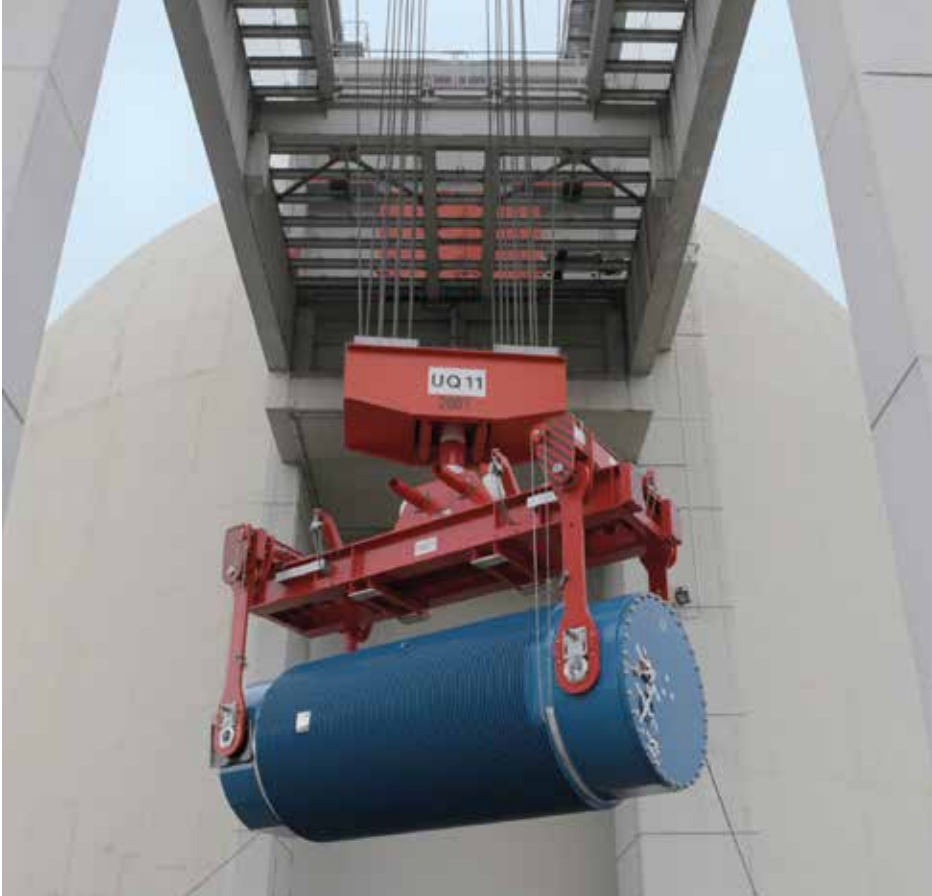
↑ AM HAKEN hängt der letzte CASTOR-Behälter aus dem abgeschalteten Block A des Bibliser Kraftwerks.
